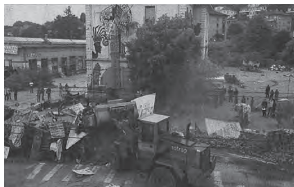
Les bulldozers en action, août 2000 © Chris Blazer
